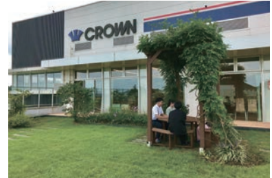
埼玉事業所の2階オープンテラスの様子
