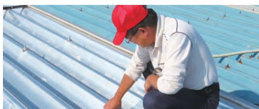
屋根の遮熱塗装で夏場の高温対策
